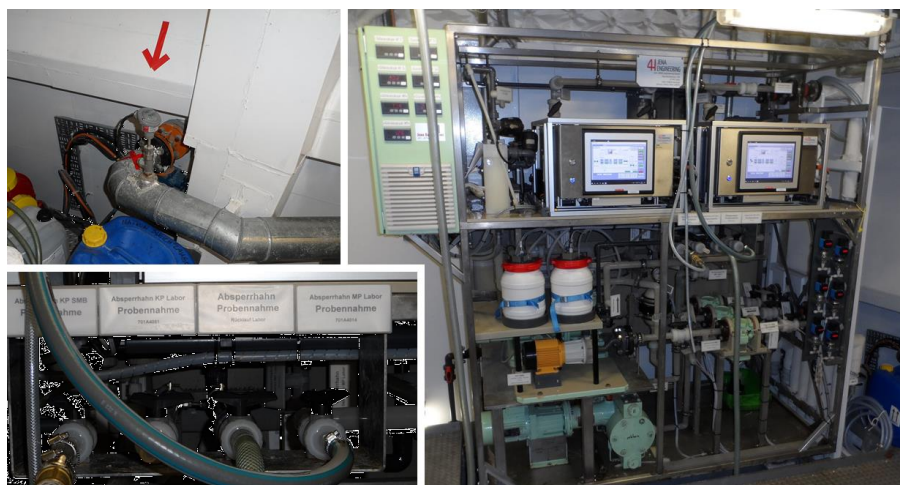
Abbildung 1 Durchflusssystem mit Einlass (Pfeil) und Probenahmeanschlüssen
